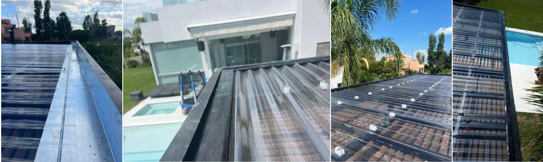
Todos nuestros techos están instalados con zinguerías completas, descargas pluviales, babetas perimetrales, incluyendo burletes compriband, tornillería galvanizada con montantes plásticos y todos los materiales necesarios para asegurar un standard de calidad alto y alargar la vida útil de su techo.
